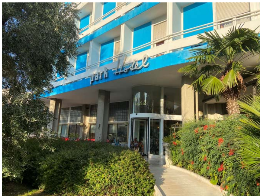
Hotel Park Terme - Via Valerio Fiacco, 31 - Abano Terme (Padova)
